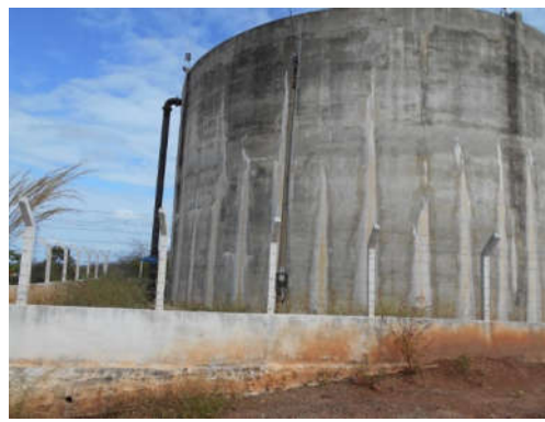
Foto 3.2 – Reservatório Apoiado – R4 – Planalto Bela Vista
