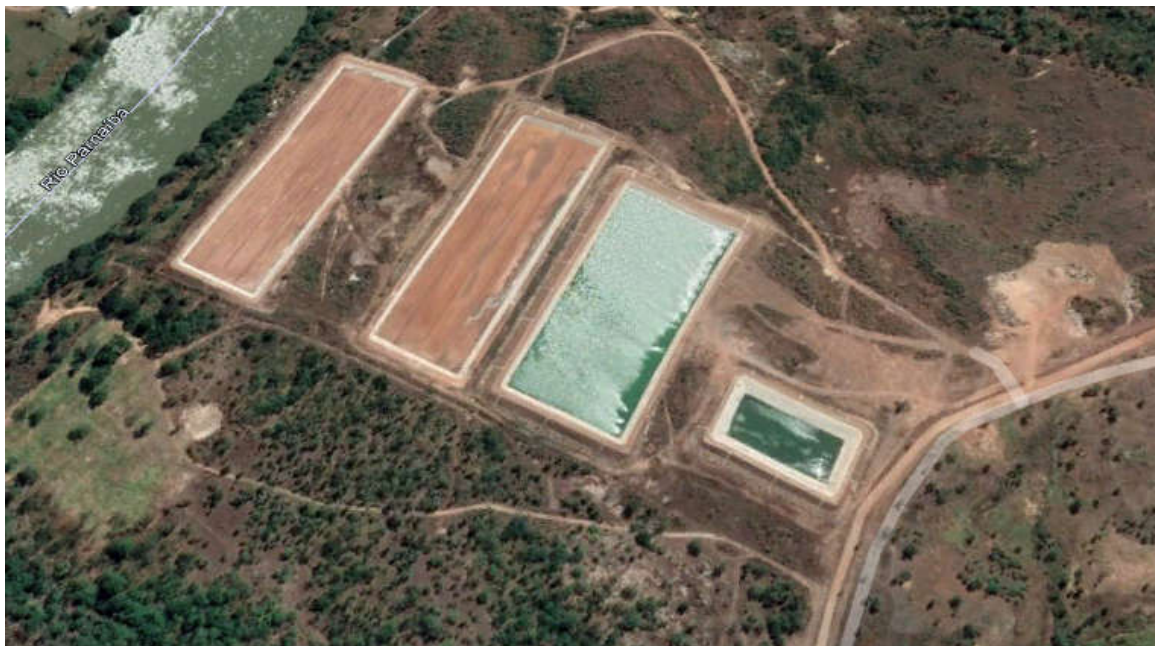
Foto 3.3 – Estação de Tratamento de Esgoto
