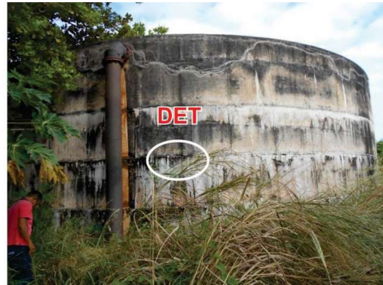
FIGURA 4.37 - RESERVATÓRIO R 03, À ESQUERDA SAÍDA DO RECALQUE DA BOMBA SUBMERSÍVEL, À DIREITA EXTRAVASOR DO RESERVATÓRIO E DETALHE DA PATOLOGIA NA PAREDE DE CONCRETO
