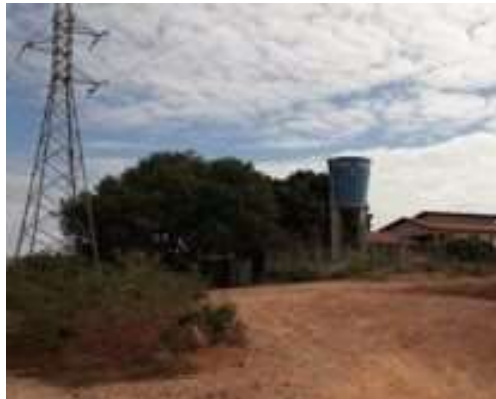
FIGURA 4.49 - RESERVATÓRIO ELEVADO DESATIVADO NA RUA ADELINO MOREIRA, BAIRRO TAMBORIL
