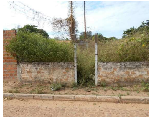
FIGURA 4.50 - POÇO P 04 DO RESERVATÓRIO ELEVADO TAMBORIL, RUA PROJETADA, 61
