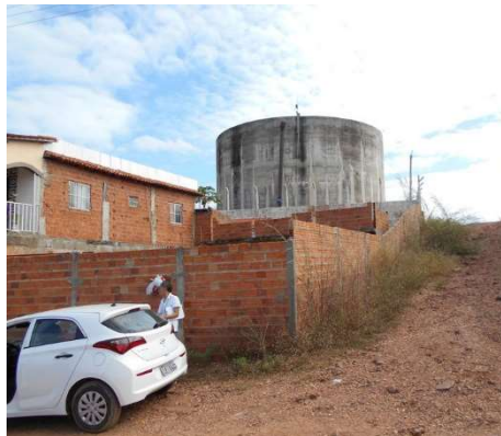
FIGURA 4.40 - RESERVATÓRIOS R 02 V=1500M 3 DESATIVADOS NO BAIRRO CAIXA D'ÁGUA
