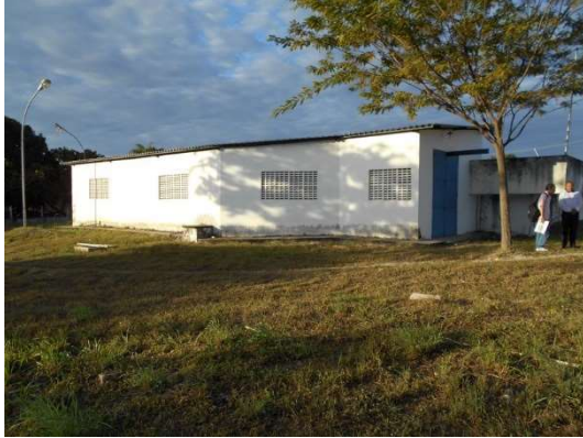
FIGURA 4.31 - VISTA DA CASA DE BOMBAS DO SISTEMA ETA-PLANALTO BELA VISTA E ETA-PLANALTO SAMBAÍBA
