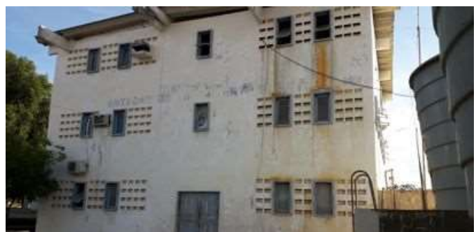
FIGURA 4.8 - VISTA FRONTAL DO PRÉDIO DA ETA
