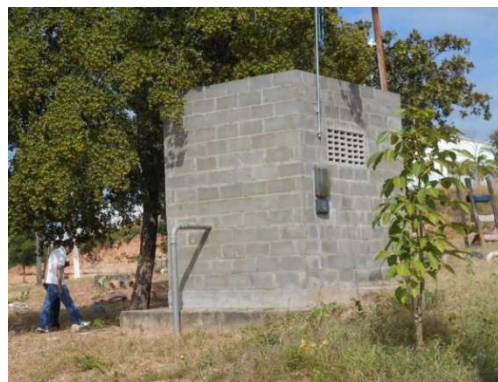
FIGURA 4.54 - POÇO P 07 NO CONJUNTO HABITACIONAL FILADÉLFIO FREITAS CASTRO, ABASTECE O RESERVATÓRIO ELEVADO EM CONCRETO DE V = 100M^3
