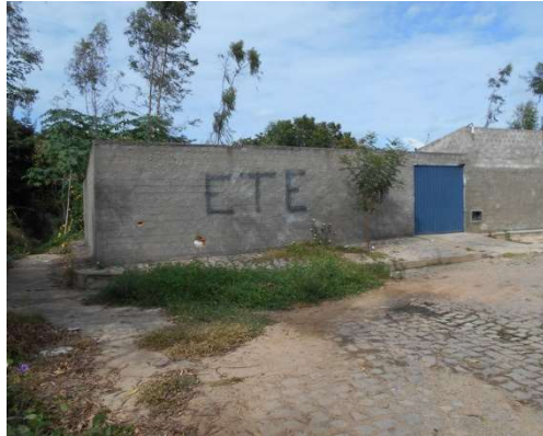
FIGURA 4.69 - VISTA DA ETE COMPACTA DO CONJUNTO HABITACIONAL FILADÉLFIO FREIRE CASTRO NO BAIRRO MELADÃO
