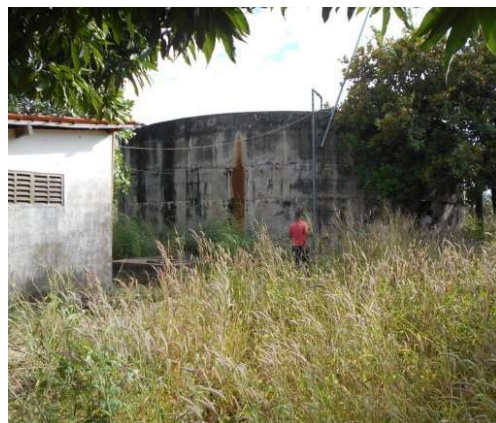
FIGURA 4.36 - RESERVATÓRIO R 03 - ALTO DA GUIA DE CONCRETO E CASA DA BOMBA DE PRESSURIZAÇÃO DA REDE DE DISTRIBUIÇÃO DA ZONA ALTA NOSSA SENHORA DA GUIA
