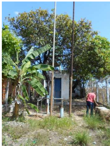
FIGURA 4.47 - POÇO P 03 NO BAIRRO CAJUEIRO II E RESERVATÓRIO ELEVADO
