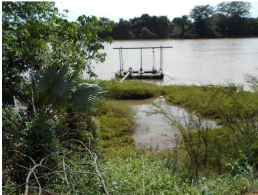
FIGURA 4.2 - CAPTAÇÃO FLUTUANTE NO RIO PARNAÍBA
