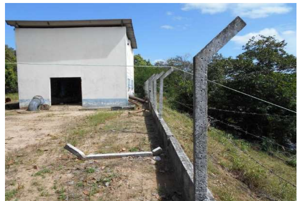
FIGURA 4.5 - VISTA LATERAL DA CASA DA ESTAÇÃO ELEVATÓRIA DE ÁGUA BRUTA
