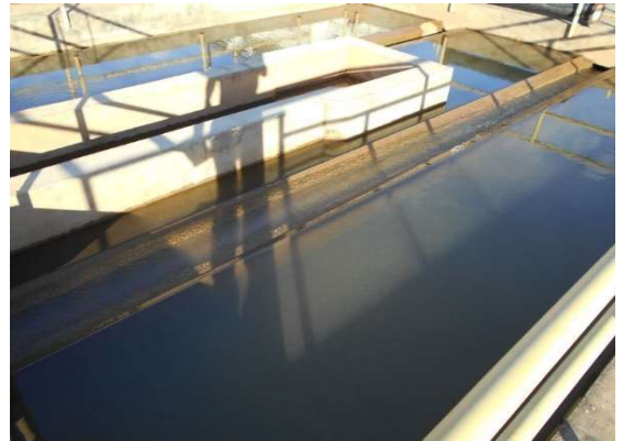
FIGURA 4.16 - NOVOS DECANTADORES SEM PLACAS VERTEDORAS V-NOTCH
