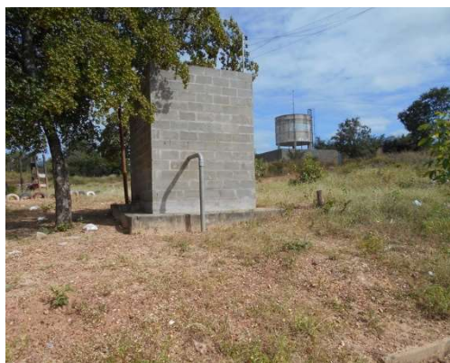
Figura 4.55 - Poço P 08. Ao fundo reservatório elevado em concreto V=100m^3 do Conjunto Habitacional Filadélfio Freitas Castro
