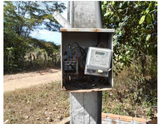
FIGURA 4.58 - ENTRADA E MEDIÇÃO DO POÇO P 01 – MELADÃO
