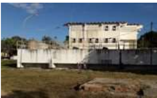
FIGURA 4.7 - VISTA LATERAL, RESERVATÓRIO R 01 EM PRIMEIRO PLANO E PRÉDIO DA ETA AO FUNDO
