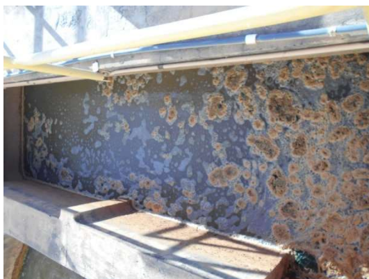
FIGURA 4.12 - ENTRADA DE ÁGUA COAGULADA NOS FLOCULADORES
