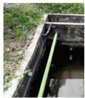
FIGURA 4.85 - CANAL DE DESINFECÇÃO DO EFLUENTE FINAL POR ULTRAVIOLETA DESATIVADO
