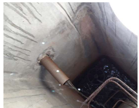
FIGURA 4.30 - VAZAMENTO EXISTENTE
