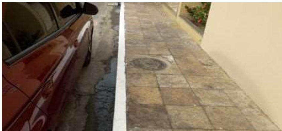
FIGURA 4.59 - CARACTERÍSTICA TÍPICA DO ESGOTAMENTO SANITÁRIO DE FLORIANO, FOSSA SÉPTICA CONSTRUÍDA DO PASSEIO. VISTA DO TAMPÃO PADRÃO
