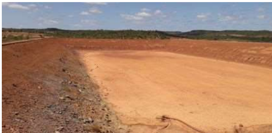
FIGURA 4.66 – VISTA GERAL DA LAGOA ANAERÓBIA
