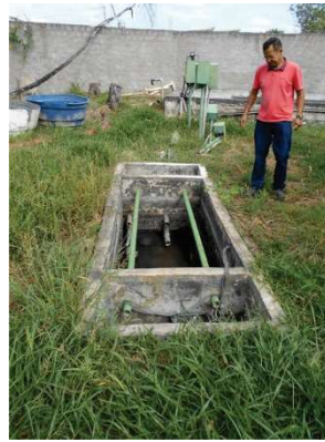
FIGURA 4.85 - CANAL DE DESINFECÇÃO DO EFLUENTE FINAL POR ULTRAVIOLETA DESATIVADO
