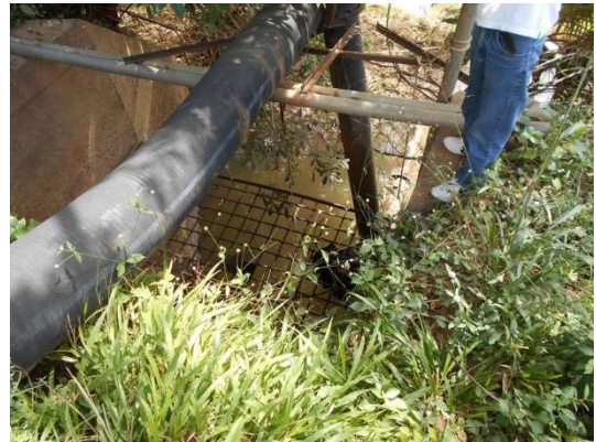
FIGURA 4.3 - CANAL DE TOMADA DESATIVADO E TUBO DO ATUAL RECALQUE DA BOMBA SUBMERSÍVEL
