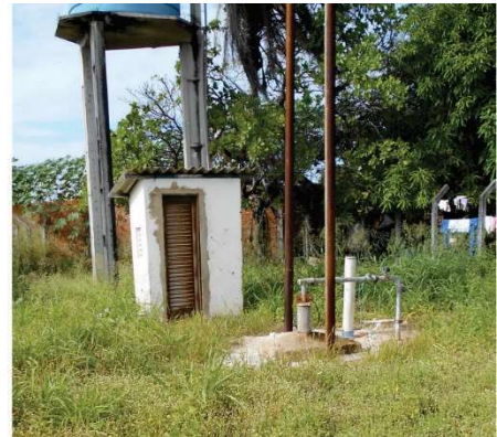
FIGURA 4.46 - POÇO P 02 E RESERVATÓRIO ELEVADO EM FIBRA DE VIDRO ( V=10M^3 ) NO BAIRRO REDE NOVA
