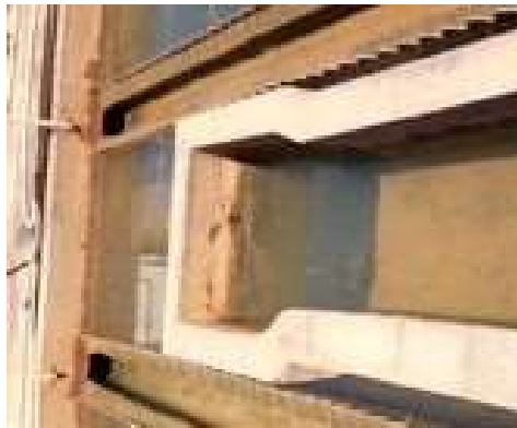
FIGURA 4.17 - CANAL DE DISTRIBUIÇÃO DE ÁGUA FLOCULADA NOS DECANTADORES
