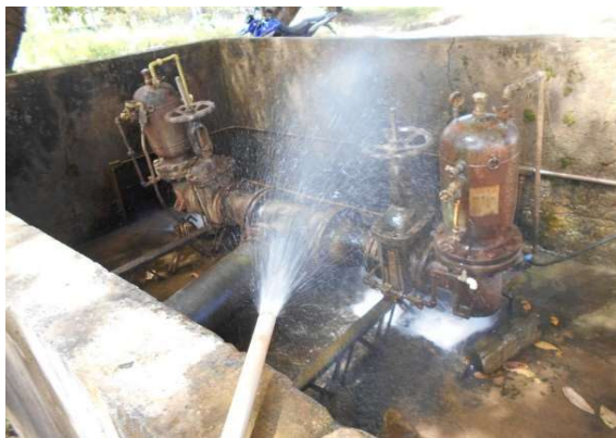
FIGURA 4.4 - VÁLVULAS ANTIGOLPE DE ARIETE NA ÁREA EXTERNA
