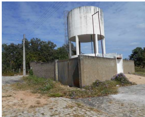
FIGURA 4.51 - RESERVATÓRIO ELEVADO EM CONCRETO ( V=100 \text{ M}^3 ) DO POÇO P 05 DO CONJUNTO JOSÉ PEREIRA
