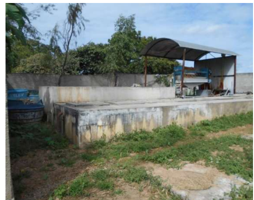
FIGURA 4.72 - VISTA LATERAL DA CAIXA DE GORDURA
