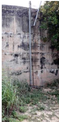
FIGURA 4.37 - RESERVATÓRIO R 03, À ESQUERDA SAÍDA DO RECALQUE DA BOMBA SUBMERSÍVEL, À DIREITA EXTRAVASOR DO RESERVATÓRIO E DETALHE DA PATOLOGIA NA PAREDE DE CONCRETO
