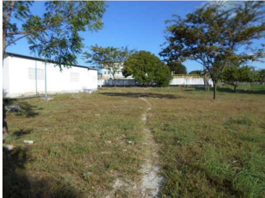
FIGURA 4.9 - VISTA LATERAL, CASA DE BOMBAS DO RESERVATÓRIO R 01 EM PRIMEIRO PLANO E ETA AO FUNDO
