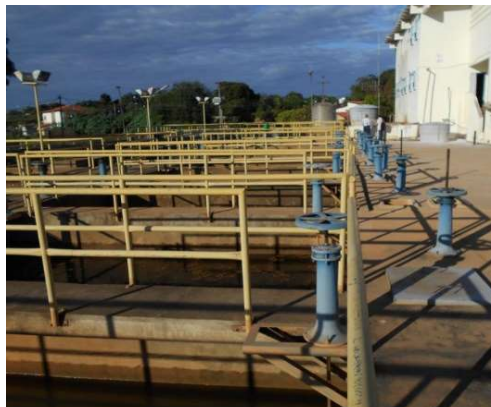
FIGURA 4.19 - LAJE DE COBERTURA DO RESERVATÓRIO DE ÁGUA TRATADA E TANQUE DE APLICAÇÃO DE HIPOCLORITO DE SÓDIO
