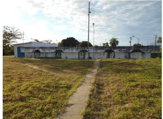
FIGURA 4.10 - RESERVATÓRIO R 01 E CASA DE BOMBAS, PLANALTO BELA VISTA E PLANALTO SAMBAÍBA
