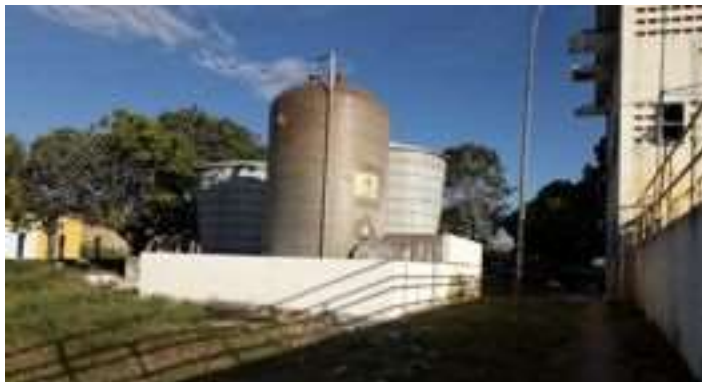
FIGURA 4.27 - TANQUES DE ARMAZENAMENTO DE PRODUTOS QUÍMICOS FLÚOR (X1) E SULFATO DE ALUMÍNIO (X2)
