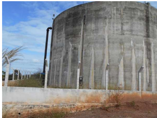
FIGURA 4.41 - LOCALIZAÇÃO DOS RESERVATÓRIOS DESATIVADOS, BAIRRO CAIXA D'ÁGUA
