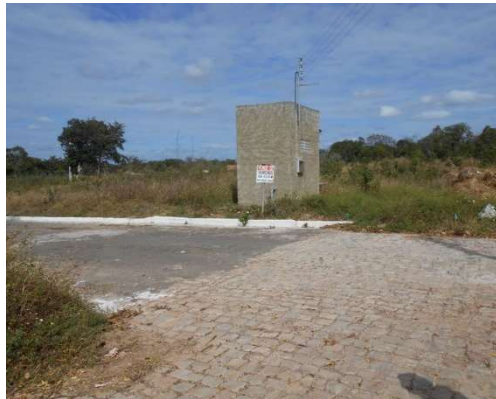
FIGURA 4.57 - POÇO P 09 DO CONJUNTO HABITACIONAL FILADÉLFIO FREITAS CASTRO. ABASTECE O RESERVATÓRIO ELEVADO EM CONCRETO V=100 M 3
