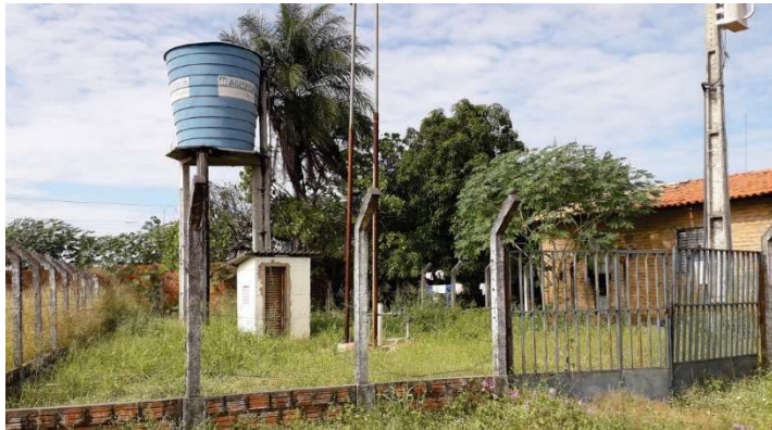
FIGURA 4.46 - POÇO P 02 E RESERVATÓRIO ELEVADO EM FIBRA DE VIDRO ( V=10M^3 ) NO BAIRRO REDE NOVA
