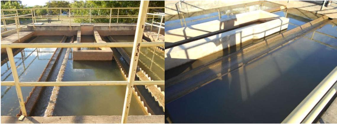
Foto 1.13 - Decantadores (4 decantadores) / Novos decantadores sem placas vertedoras V-Notch
