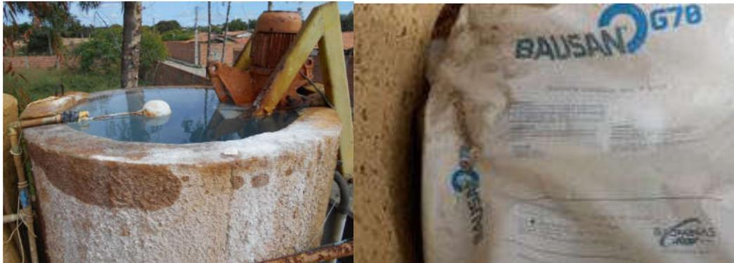
Foto 1.46 - Tanque de preparo de hipoclorito de cálcio granulado - Tanque de preparo de sulfato de alumínio desativado
