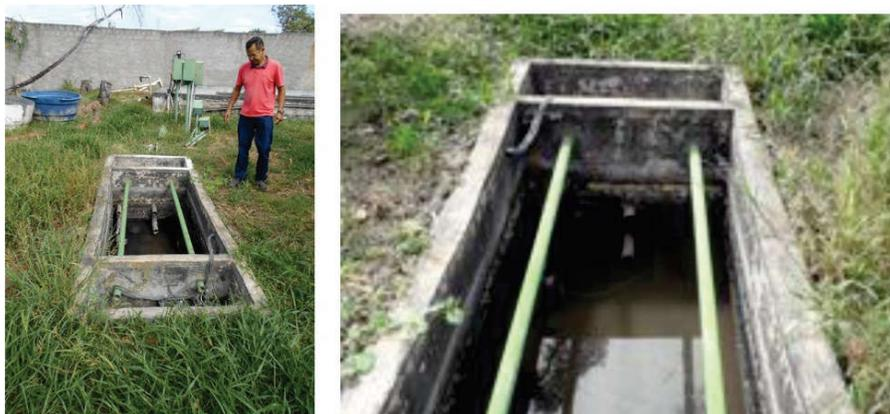
Foto 1.50 - Canal de desinfecção do efluente final por ultravioleta desativado
