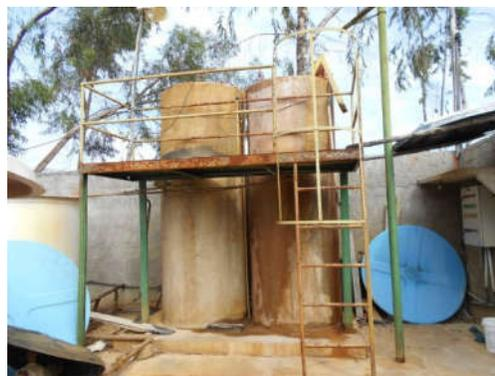
Foto 1.47 - Plataforma de acesso aos tanques de preparo de solução de hipoclorito de cálcio e sulfato de alumínio desativado. Plataforma em avançado grau de oxidação
