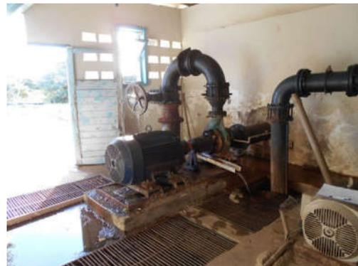
Foto 1.18 – Conj. motobomba para recalque ao reservatório Alto da Guia, sucção no reservatório de água filtrada da ETA. Inexistência de válvula de bloqueio na sucção / Conj. motobomba reserva para recalque ao reservatório Alto da Guia com vazamento pela gaxeta, inexistência de válvula de bloqueio na sucção
