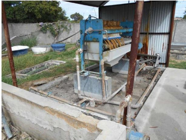
Foto 1.49 - Filtro prensa para desidratação de lodo desativado
