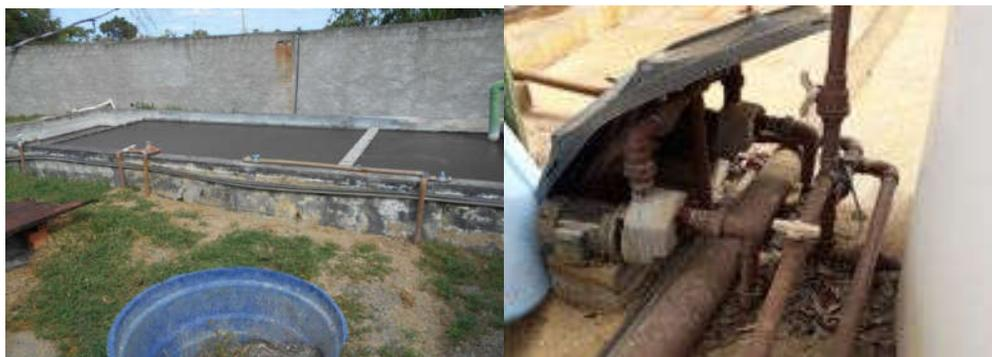
Foto 1.48 - Tanque de decantação aplicação de hipoclorito e saída para lançamento Corpo Receptor - Bombas centrífugas do sistema de preparo de produtos químicos
