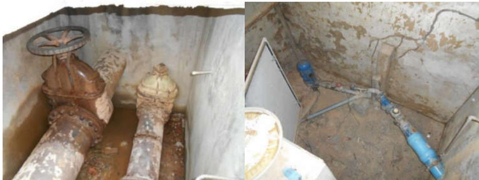
Foto 1.23 - Tubulação de alimentação ( $\varnothing 350\text{mm}$ ) do reservatório R 03 – Alto da Guia e saída para distribuição (250mm) - Bomba centrífuga para pressurização da rede do Bairro N<sup>a</sup> Senhora da Guia, alimentada pela bomba submersível instalada no reservatório R 03
