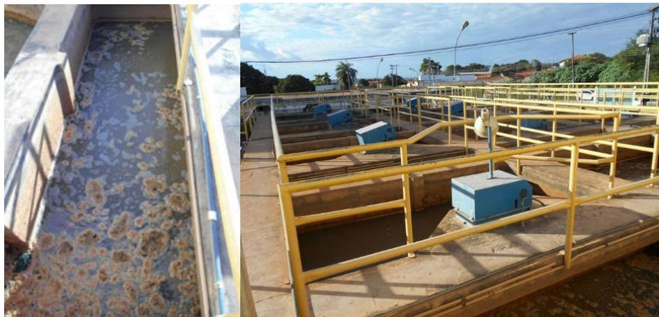
Foto 1.1 - Entrada de água coagulada nos flocladores e Unidade de Floclação (4 tanques c/3 agitadores)
