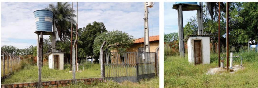
Foto 1.27 - Poço P 02 e reservatório elevado em fibra de vidro (V=10m3) no bairro Rede Nova
