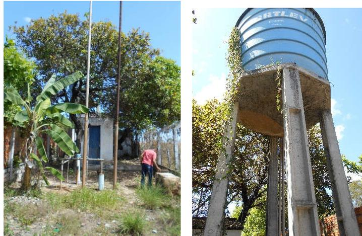
Foto 1.28 - Poço PTP 03 no bairro Cajueiro II e REL – REL do PTP 03 em fibra de vidro (V = 15 m<sup>3</sup>) no Bairro Cajueiro
