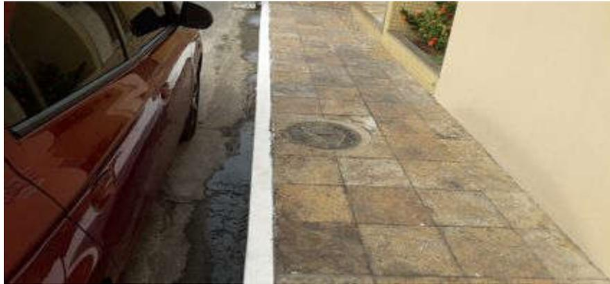
Foto 1.34 - Característica típica do esgotamento sanitário de Floriano, fossa séptica construída do passeio. Vista do tampão padrão
