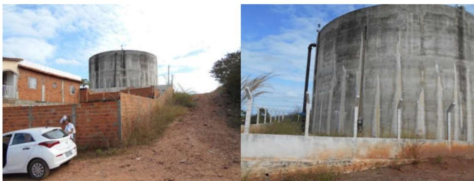
Foto 1.25 - Reservatório R 04, apoiado em concreto V=1500m3 (Planalto Bela Vista) - Reservatório R 04 Planalto Bela Vista, tubulação de entrada
