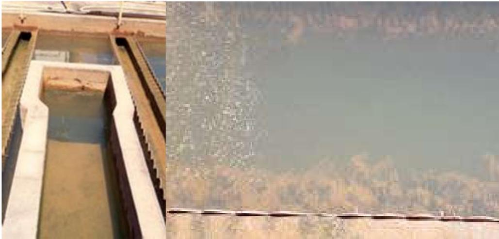
Foto 1.14 - Canal de distribuição de água floculada nos decantadores e Decantadores com módulos tubulares de decantação danificados
