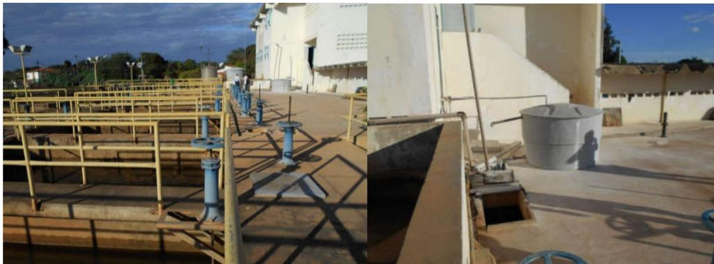
Foto 1.15 – Vista do reservatório de água tratada e tanque de aplicação de hipoclorito de sódio - Ponto de aplicação de cal e hipoclorito de sódio no tanque de água filtrada
