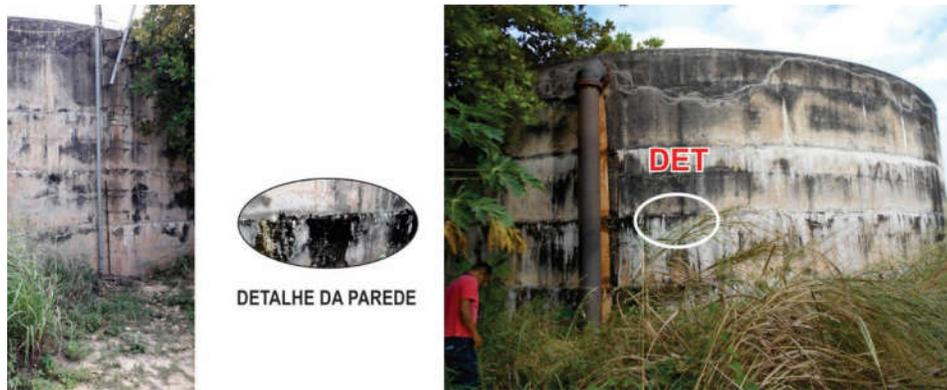
Foto 1.22 - Reservatório R 03, à esquerda saída do recalque da bomba submersível, à direita extravasor do reservatório e detalhe da patologia na parede de concreto
