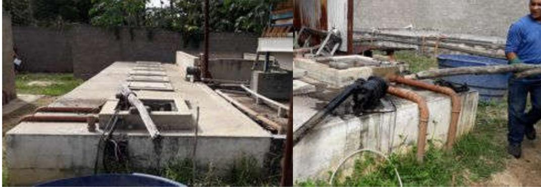
Foto 1.43 - Caixa de gordura e abertura da bomba de recalque ao tanque anaeróbio - Caixa de gordura e abertura da bomba de recalque ao Tanque Anaeróbio
