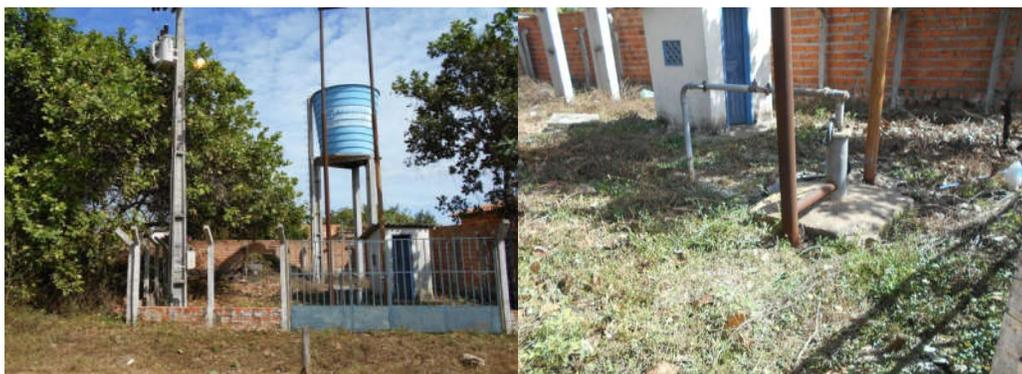
Foto 1.26 - Poço P 01 e reservatório elevado em fibra de vidro (V=10 m3) no bairro Meladão Figura 0.2 -
