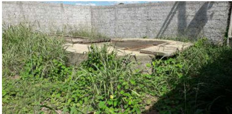
Foto 1.32 - Situação atual da estação elevatória de esgoto EEE 03 com muro de fechamento executado e sem instalação hidromecânica e eletromecânica
