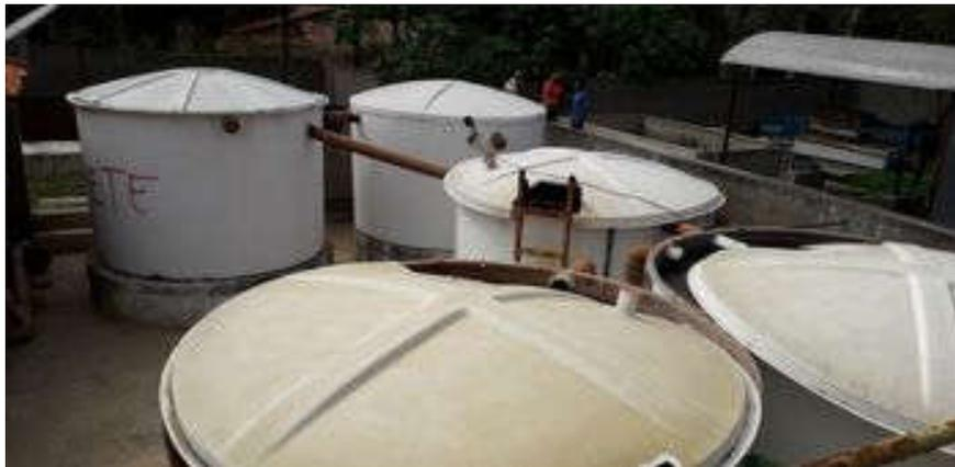
Foto 1.44 - Vista geral dos tanques de processo, tanques anaeróbios, tanques de aeração e de decantação
