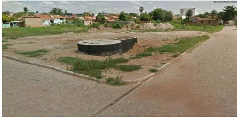
Foto 1.31 - Estação elevatória de esgoto EEE 03 na Rua Fernando Marques no bairro Bosque Santa Terezinha - Poço de sucção e caixa de barrilete construídos. (Fonte da imagem: Google Earth)
