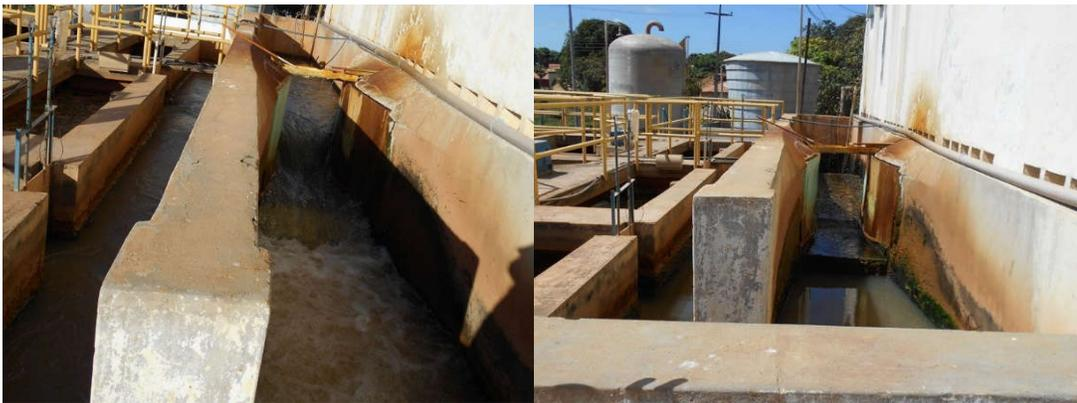
Foto 1.11 - Chegada de água bruta, calha Parshall e aplicação de coagulante / Vista da Calha Parshall operação
