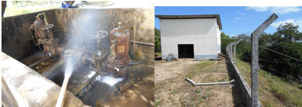
Foto 1.7 - Válvulas antigolpe de aríete na área externa e vista lateral da casa da estação elevatória de água bruta
