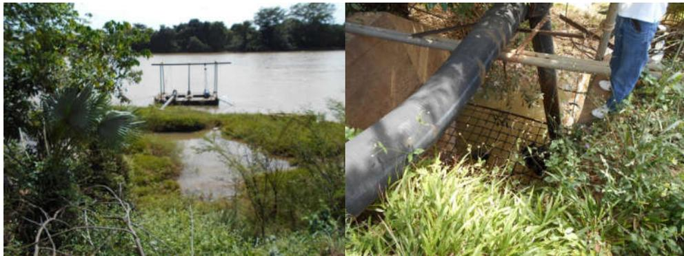
Foto 1.6 - Captação flutuante no rio Parnaíba, Canal de tomada e recalque da bomba submersível
